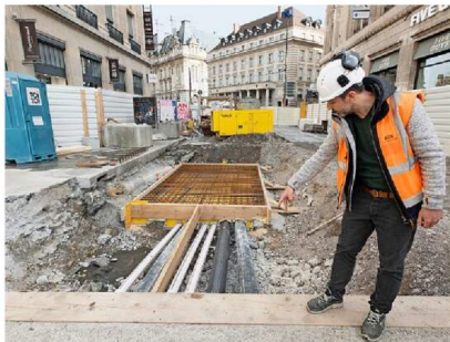
La fibre optique passe dans des tuyaux neufs. FLORIAN CELLA
